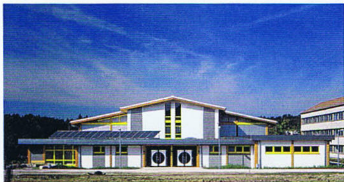
Die Doppelsporthalle entstand in wirtschaftlicher Massivholzbauweise.
