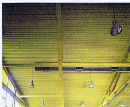
In die Schlitze der raumseitig fertigen Elementoberflächen wurden entsprechend der akustischen Anforderungen schon im Werk Absorberstreifen eingebracht.
