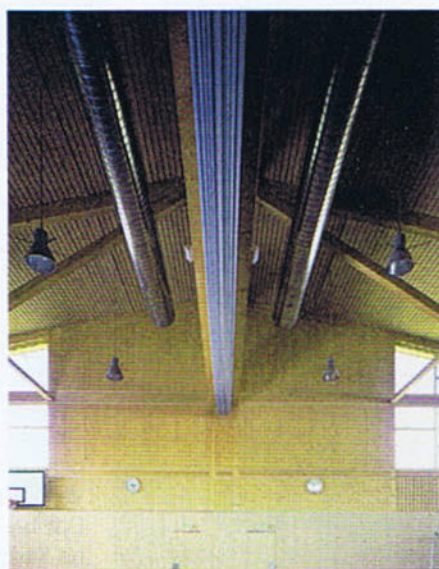
Das Hallendach besteht aus Akustik-Elementen; diese speziellen Holzblocktafeln sind bis zu einer Spannweite von 9 m selbsttragend.
